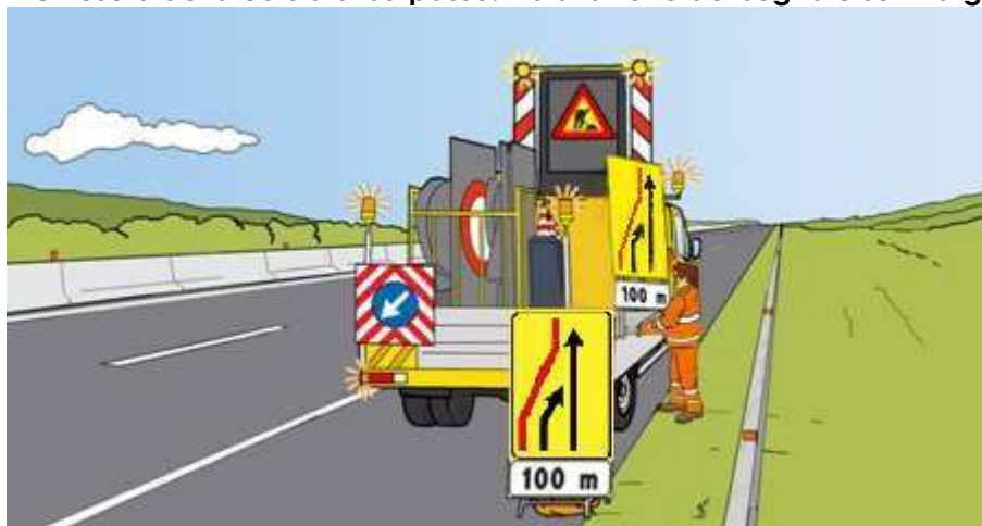
Figura 30 – Chiusura della corsia di sorpasso: scarico ed installazione del segnale di esclusione della corsia sul margine destro
