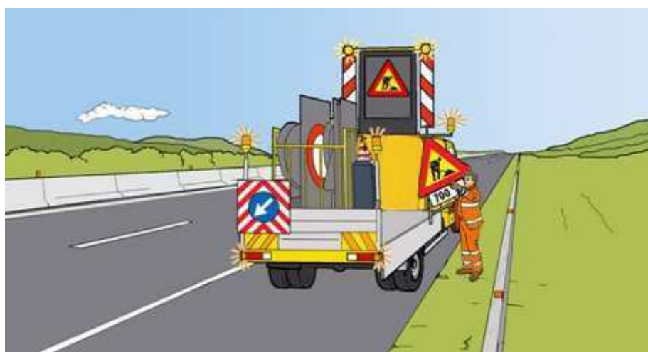
Figura 27 – Chiusura della corsia di sorpasso: scarico ed installazione del segnale di lavori in corso sul margine destro
