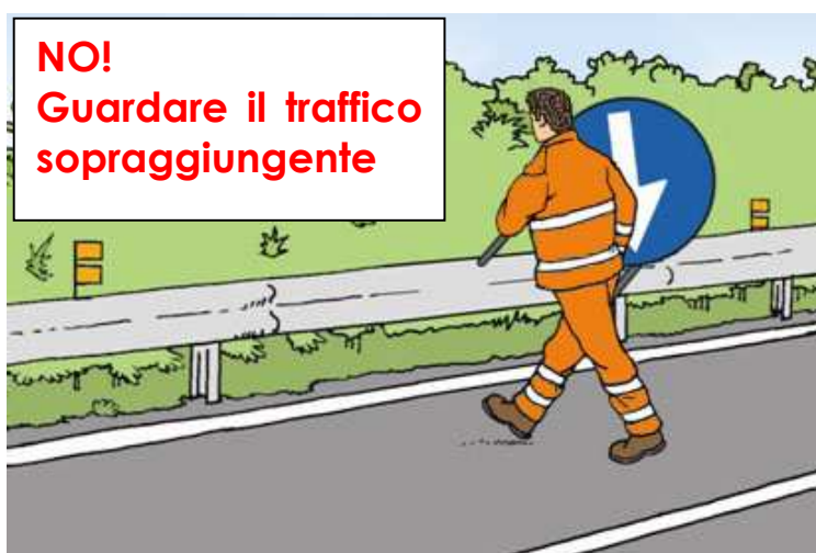
Figura 17 – Trasporto manuale della segnaletica
