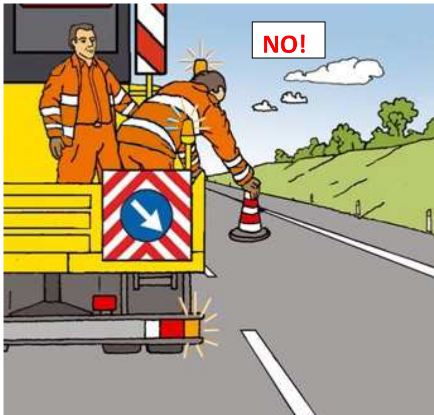
Posizionamento dei coni o dei delineatori flessibili: comportamento scorretto
