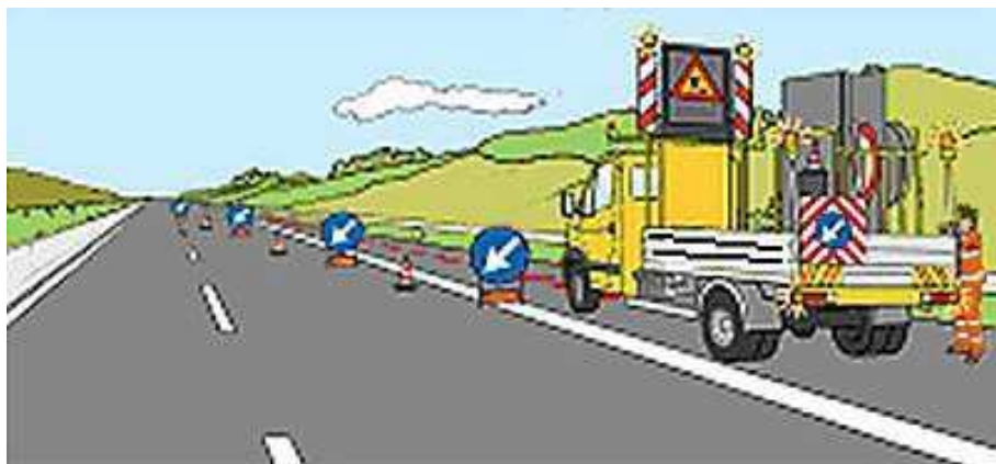
Figura 25 – Chiusura della corsia di marcia: installazione della testata di esclusione della corsia
